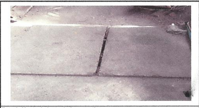
Foto 6: Mantenimiento de fosa septica
